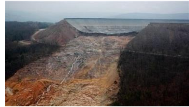
Falla de la reserva Taum Sauk
