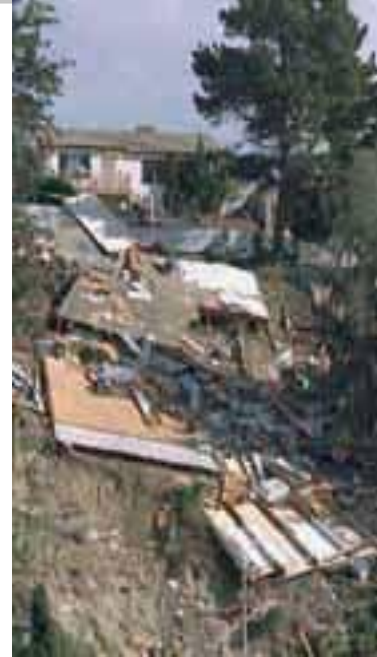
Desprendimiento en el terremoto de Northridge 1989
