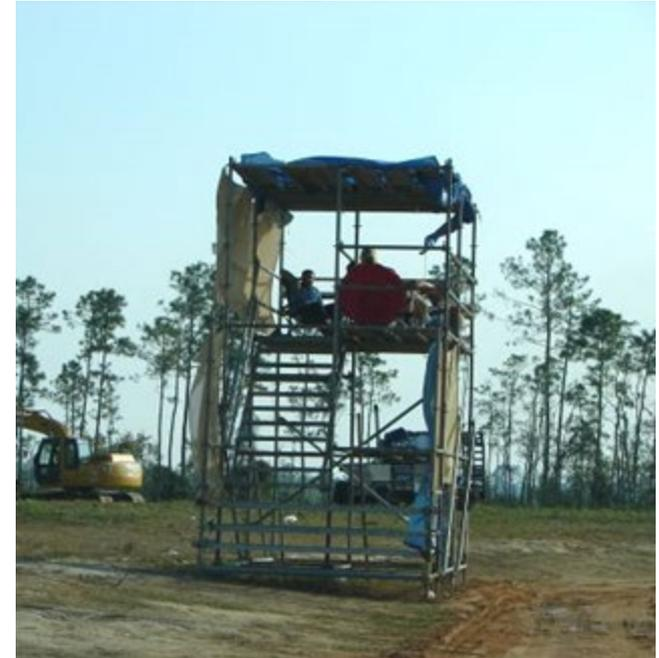
Esta torre está hecha para inspeccionar los camiones de escombros que se dirigen a los botaderos. El inspector está expuesto al tráfico vehicular que viaja cerca de la torre. Observe en esta foto la falta de una zona de protección alrededor de la torre. Debería haber marcas visuales como conos, señales o cintas para que los conductores puedan identificar la torre.
